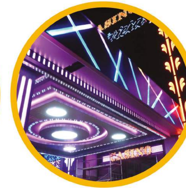
CIELO RASO CON ILUMINACIÓN LED
