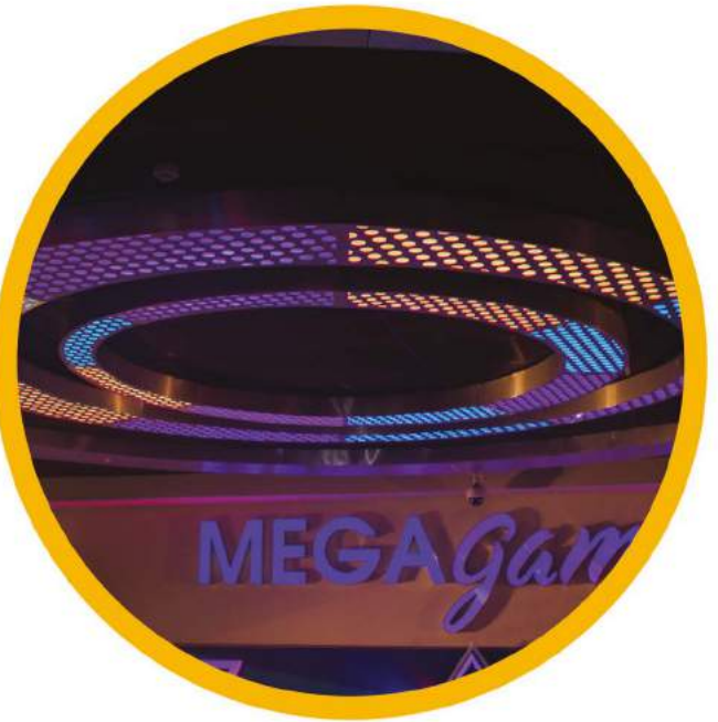
CIELO RASO EN ALUMINIO TROQUELADO CON ILUMINACIÓN LED
